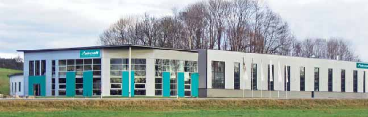
Abb. zeigt das neue 2006 fertiggestellte Fertigungs- und Verwaltungsgebäude in Österreich.
